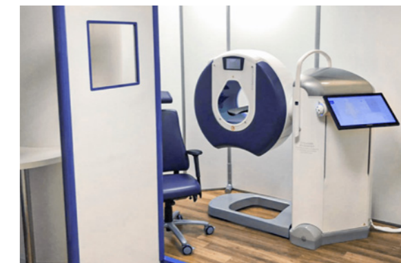
In temporär verfügbaren Räumen: Mobile Strahlenschutzwände schirmen die umgebenden Räume normgerecht ab.
